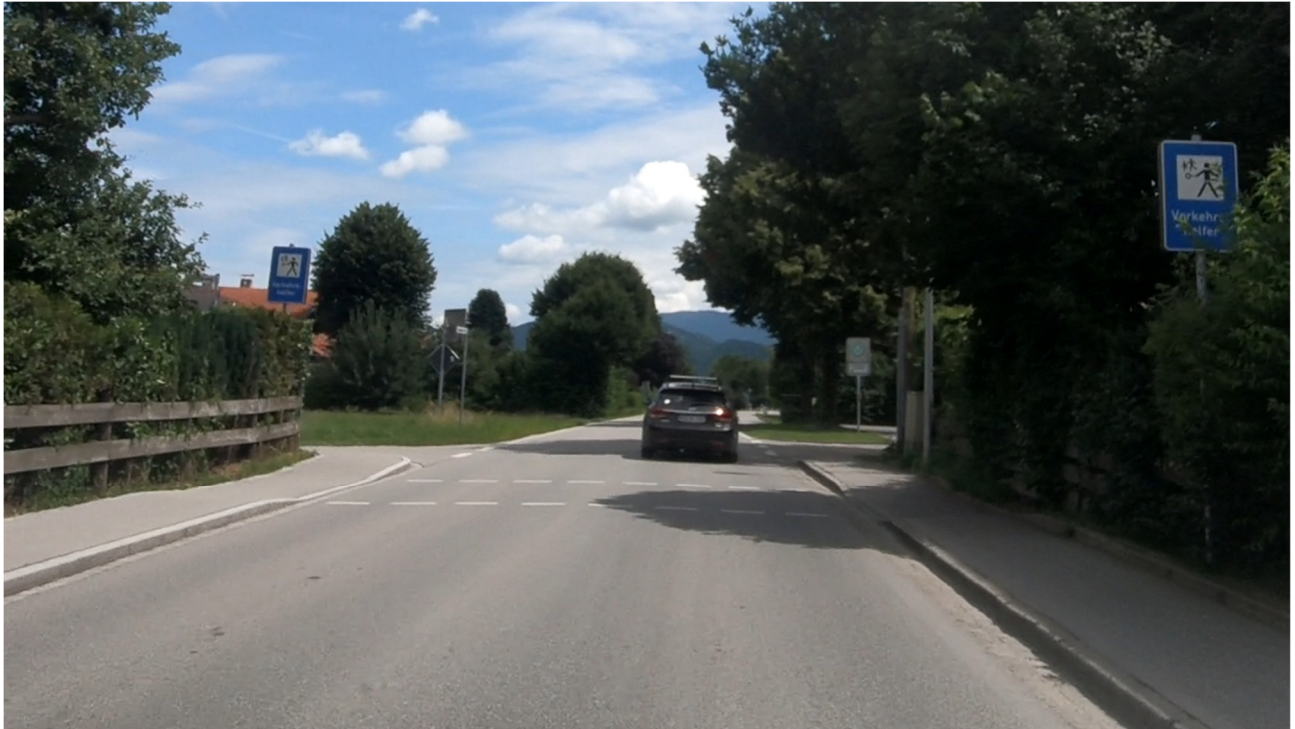
Abbildung 2-38: Fußgängerfurt Großholzhausen – Blickrichtung Osten
